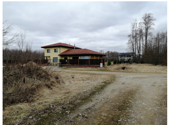
Foto 6. Vaade Pistriku tänavalt elamukrundile – Pistriku vkt 16
